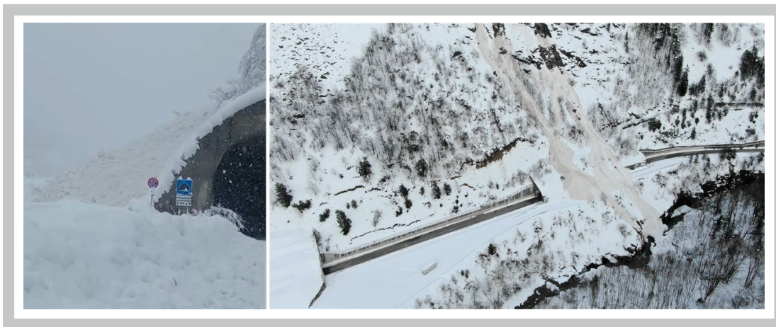
Figura 28: Vista della stessa valanga che ha oltrepassato la galleria Messantoni. A sinistra lo scatto della CLV Valle Stura proprio durante la discesa della valanga avvenuto il 4 marzo. A destra la valanga vista dall'alto con una colorazione rossastra che deriva dalle deposizioni di origine sahariana presenti nel manto nevoso
