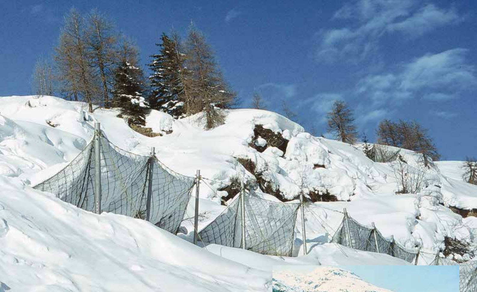
Sopra: reti metalliche.
