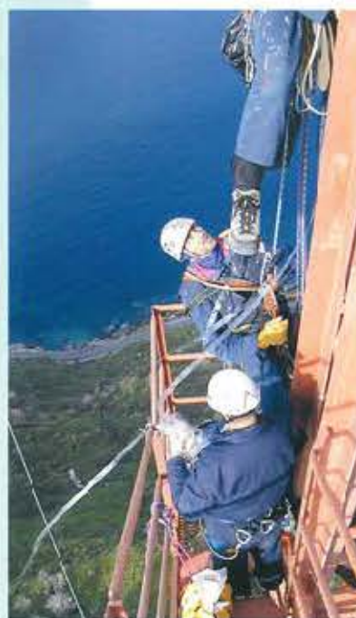
Le Guide di Alagna sul pilone dello Stretto di Messina, al lavoro a oltre 200 metri di altezza dal suolo.
