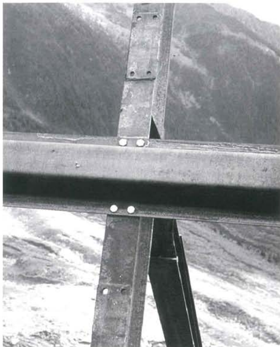
Sopra: particolare del collegamento della griglia ai montanti.
