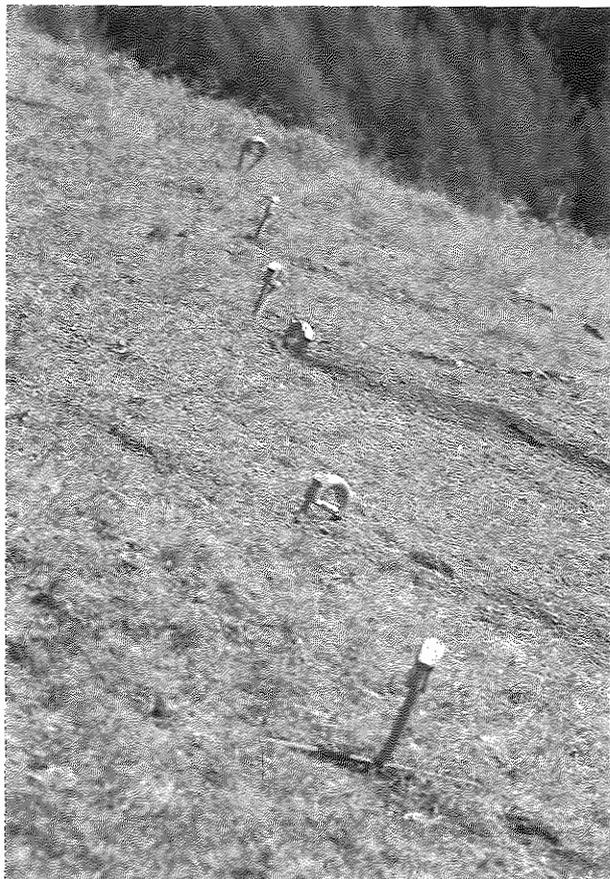
Fig. 3 Ancoraggi del tipo "piolo esplosivo" realizzati per la posa in opera di fermandeve in rete d'acciaio; si noti l'assoluta mancanza di danni dovuti all'incisione del versante.
