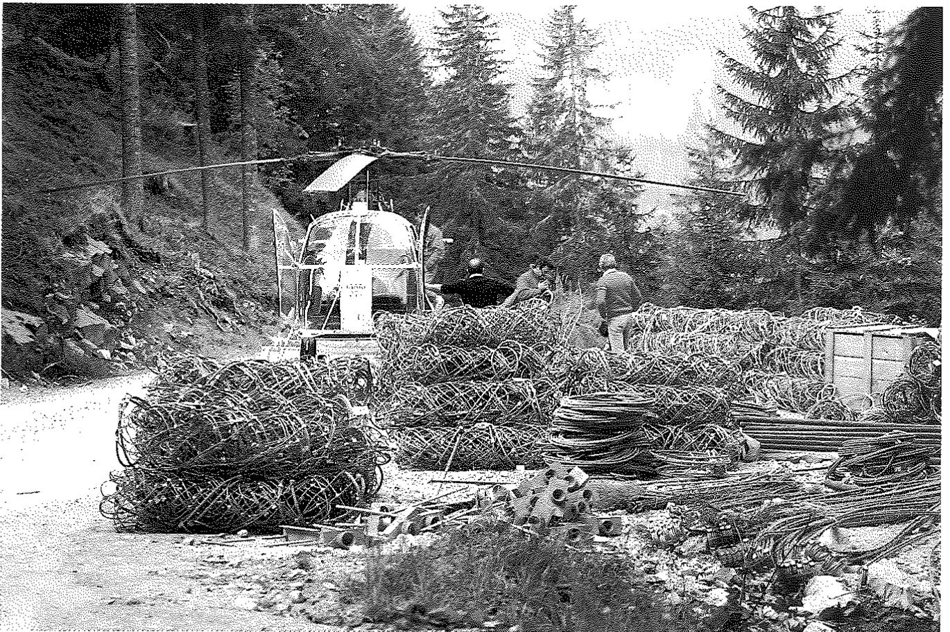
Fig. 3 Stoccaggio delle reti da neve all'imposto camionabile per il trasporto con elicottero.
