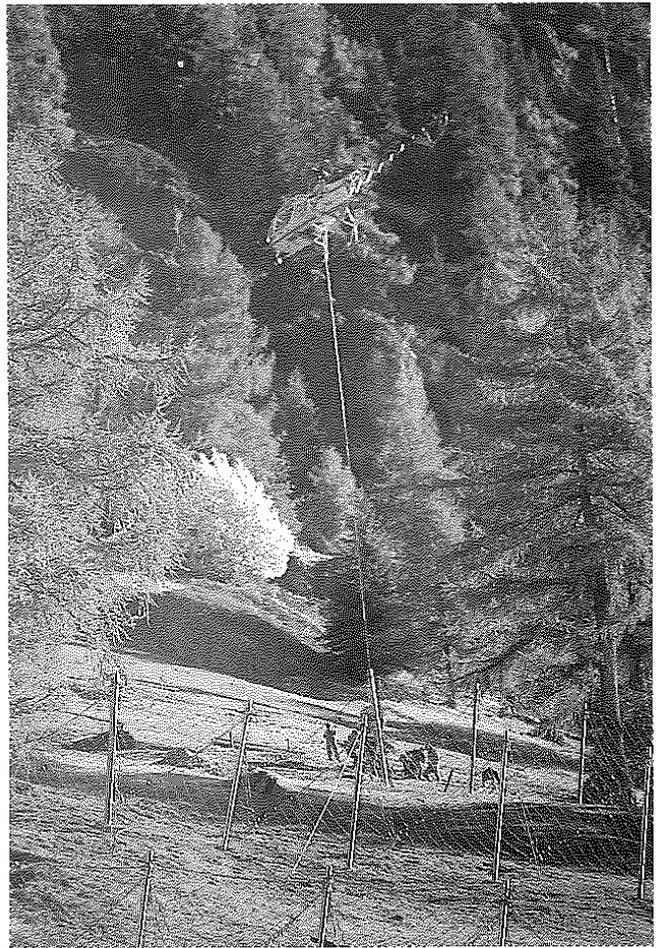
Fig. 4 Dislocazione degli elementi costituenti le reti da neve lungo le file mediante l'utilizzo dell'elicottero.
