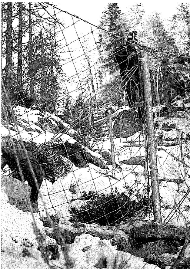
Fig. 7 Ultime fasi di montaggio delle barriere fermaneve elastiche.
