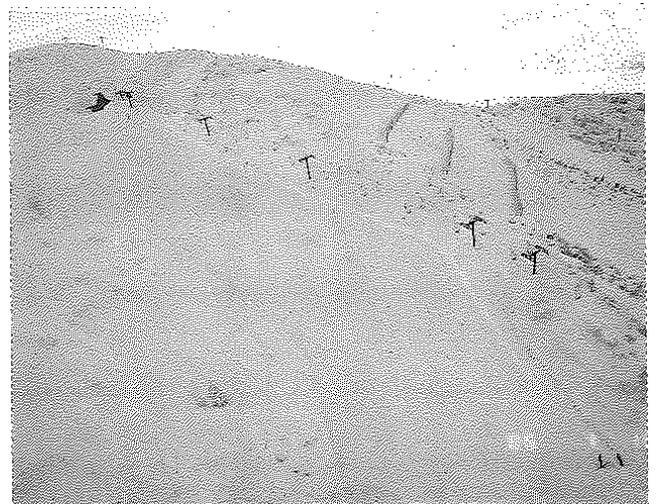
Fig. 1 Sistema di opere paravalanghe realizzato con reti. (versante Ovest di Cima Palon - Monte Bondone - Trento).
