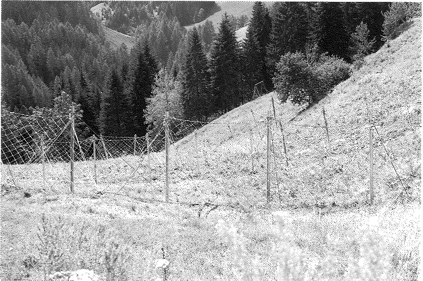
**Fig. 1** Particolare di un intervento di sistemazione mediante barriere fermaneve elastiche del tipo "reti da neve".
