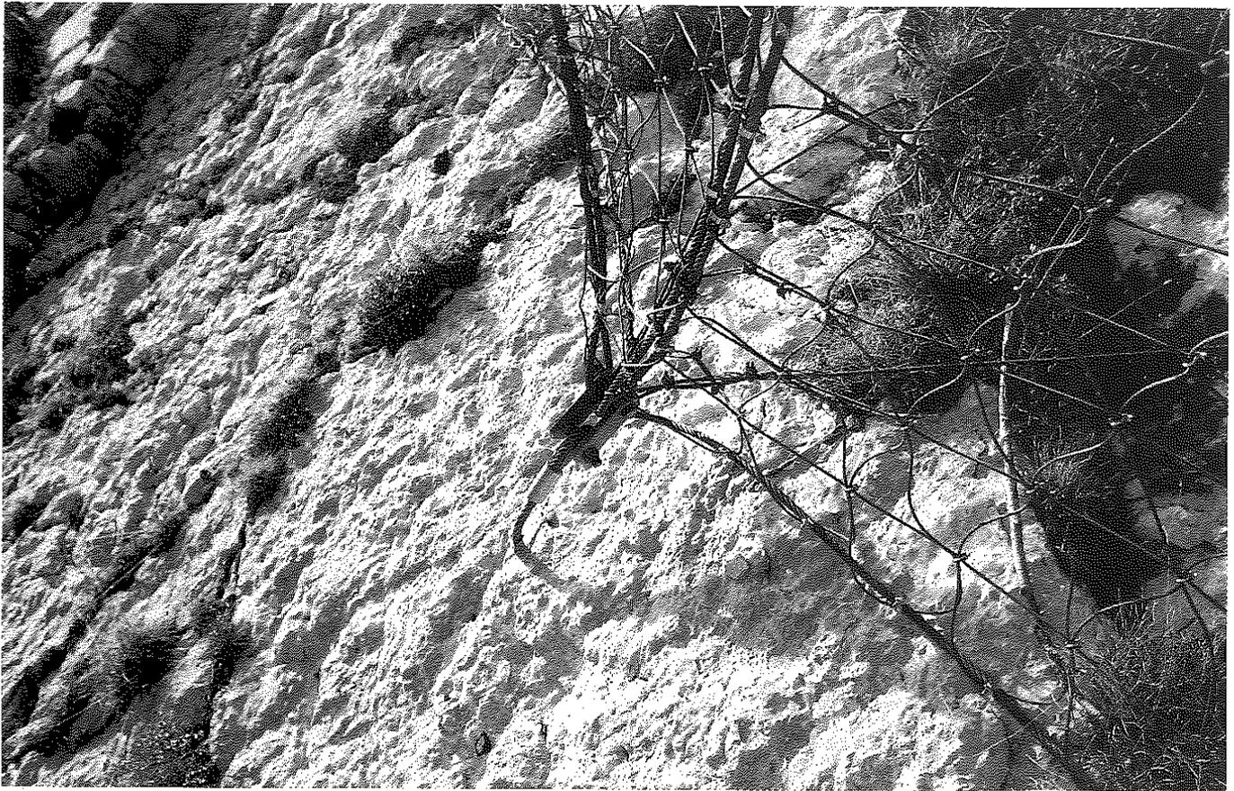
Fig. 4 Particolare dell'ancoraggio della rete alla roccia, mediante cavo bloccato con resine epossidiche. (Versante Ovest di Cima Palon - Trento).
