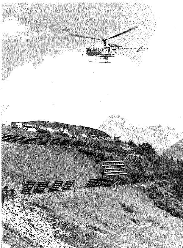
Fig. 6 Trasporto e messa in opera di struttura, premontata a valle, a mezzo di elicottero.
