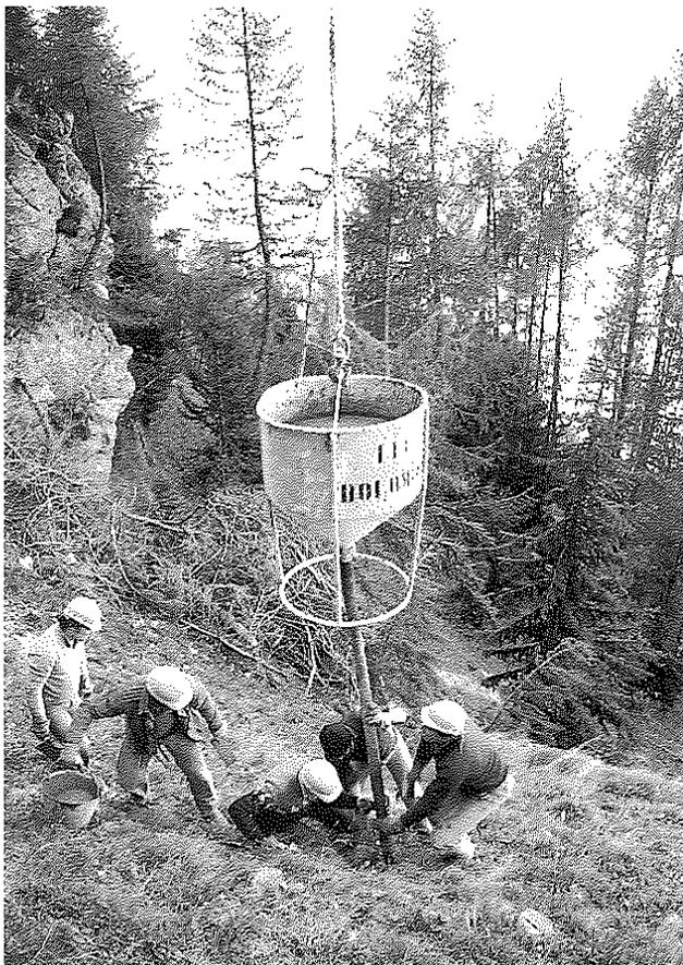
Fig. 6 Iniezione a pressione di malta cementizia di un micropalo con l'utilizzo dell'elicottero.
