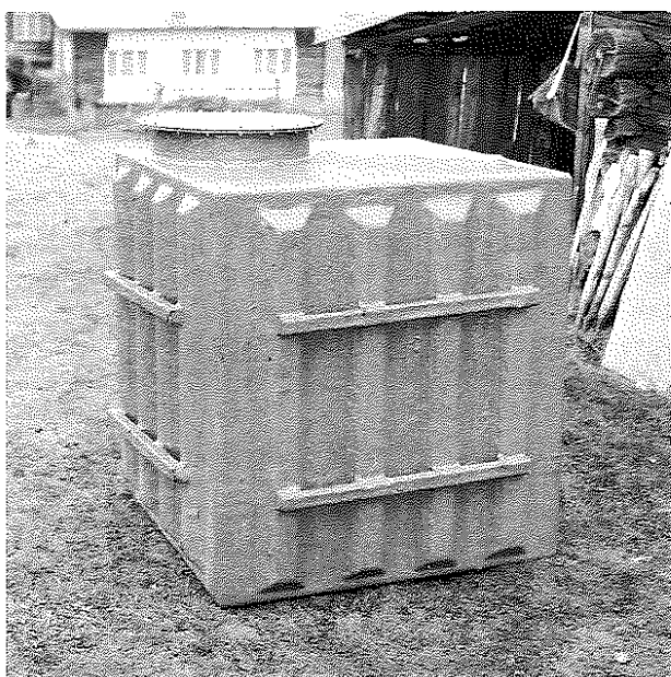
Fig. 4 Pozzo di oscillazione con passo d'uomo per l'ispezione (Foto: Ufficio Idrografico-Servizio Prevenzione Valanghe - Provincia di Bolzano)
