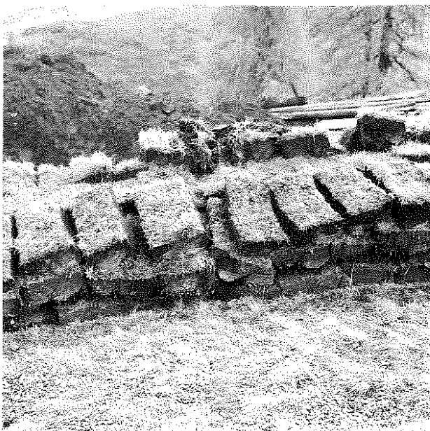
Fig. 1 Asportazione della cotica erbosa, in fase di scavo che verrà riposizionata a lavori ultimati (Foto: Ufficio Idrografico-Servizio Prevenzione Valanghe - Provincia di Bolzano)
