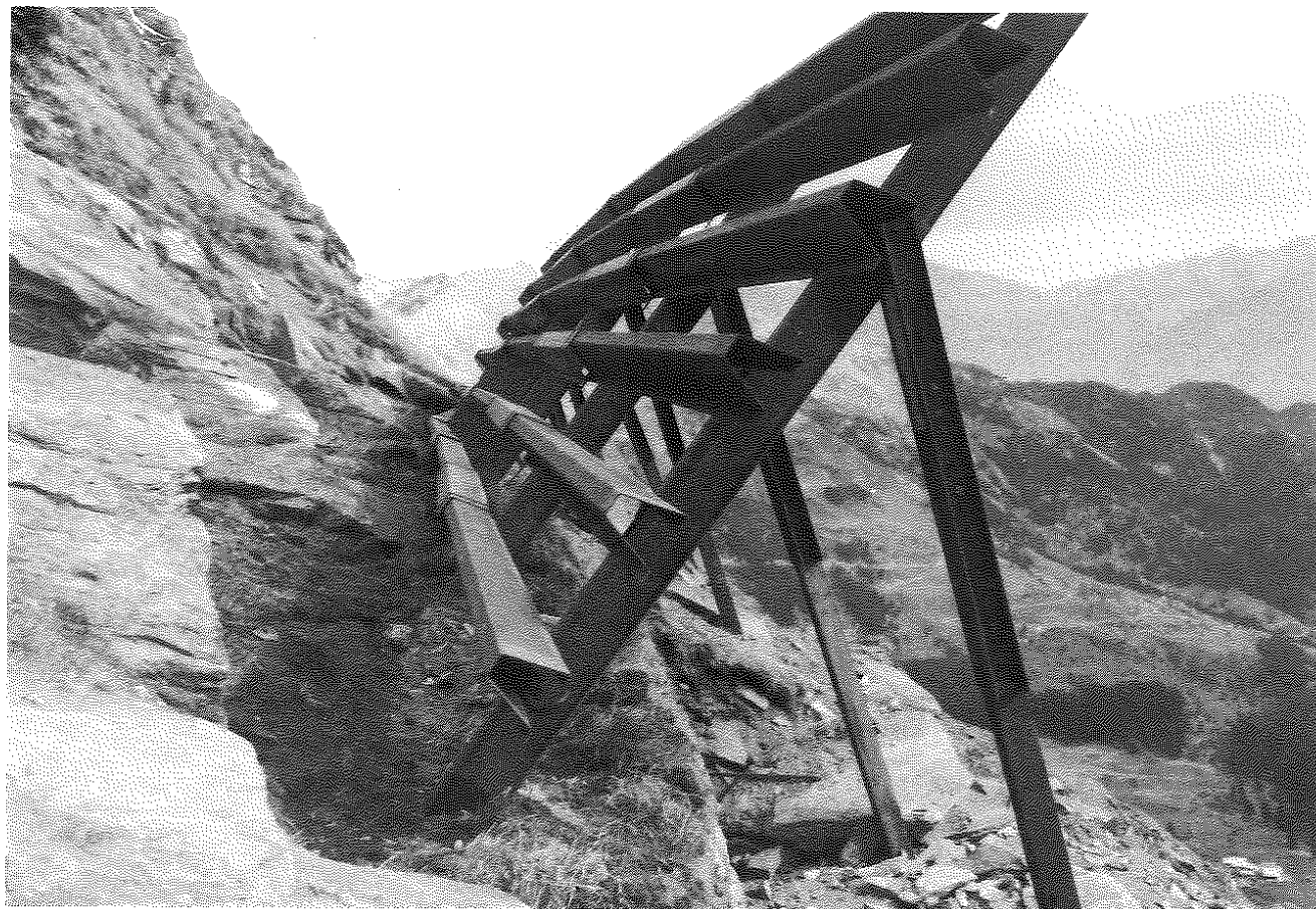
Fig. 5 Particolare di ponte da neve con fondazioni su roccia (Foto: Regione Valle d'Aosta)
