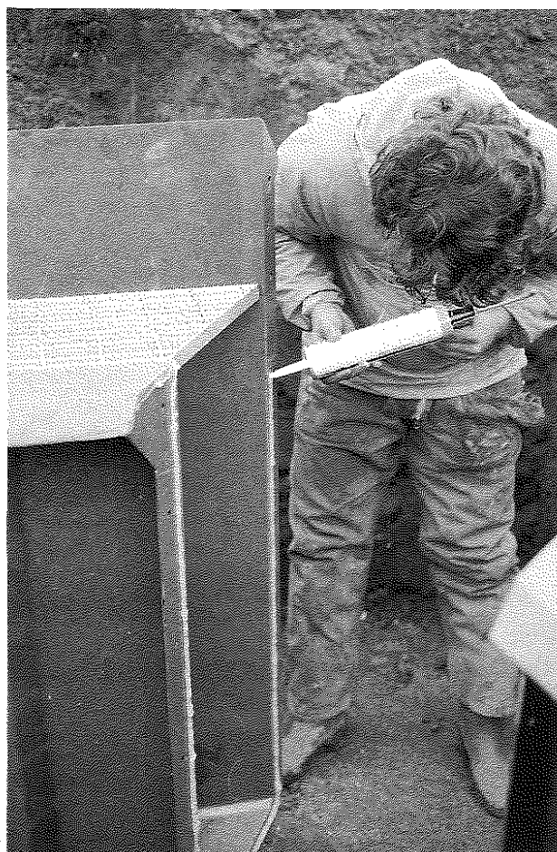
Fig. 6 Sigillatura delle giunzioni (Foto: Ufficio Idrografico-Servizio Prevenzione Valanghe - Provincia di Bolzano)
