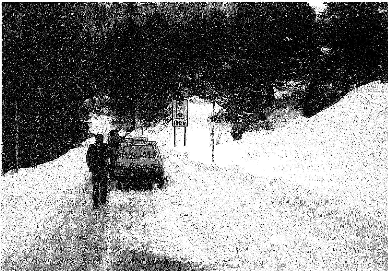
Fig. 2 Semaforo delle valanghe sulla Strada Provinciale di Vallorsa. (Foto: Provincia Autonoma di Trento - Settore Neve e Valanghe)
