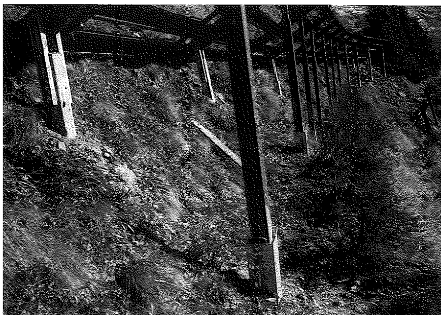
Fig. 3 Fondazioni realizzate con "pali radice" o "micropali".
