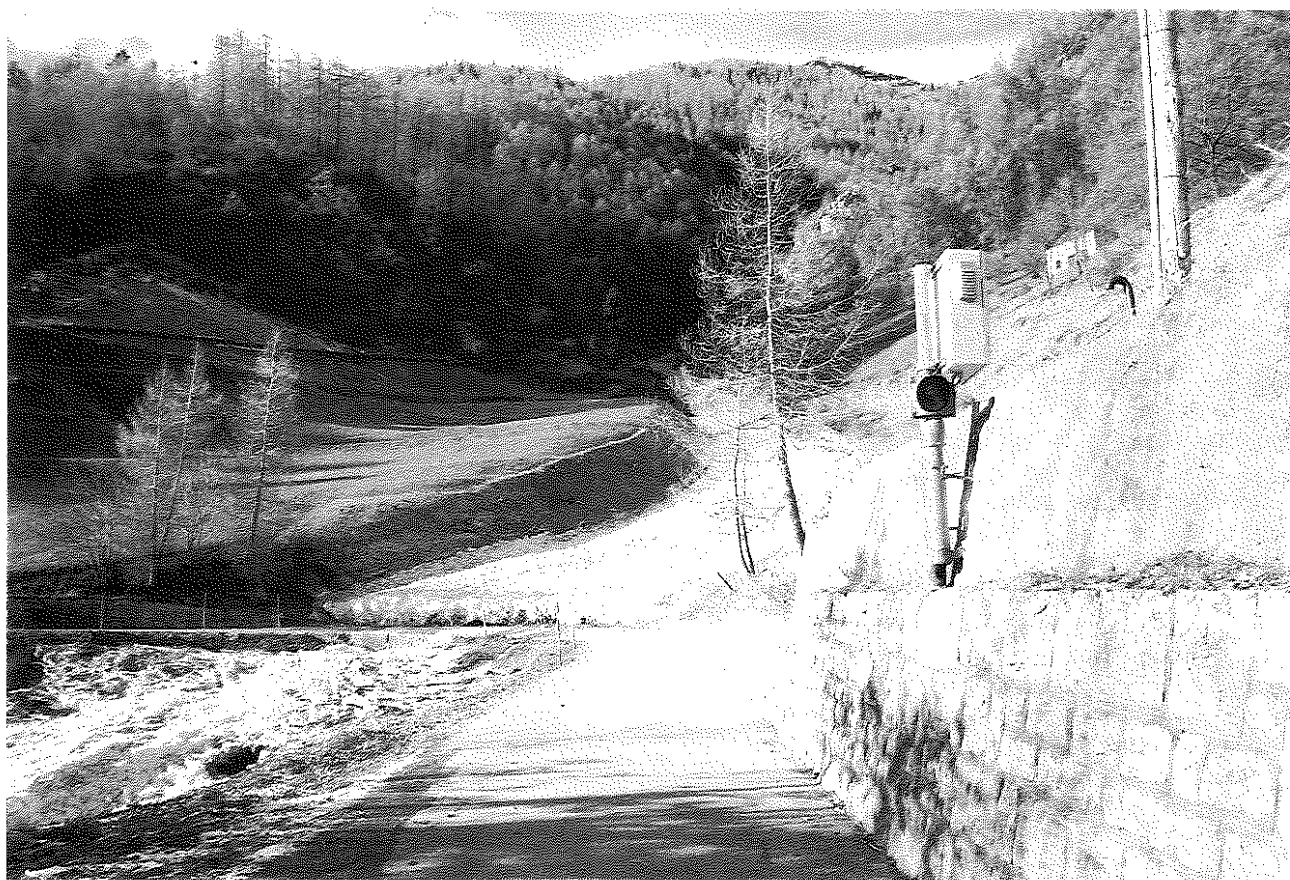
Fig. 1 Semaforo delle valanghe sulla Strada Provinciale di Montes, Val di Sole. (Foto: Provincia Autonoma di Trento - Settore Neve e Valanghe)
