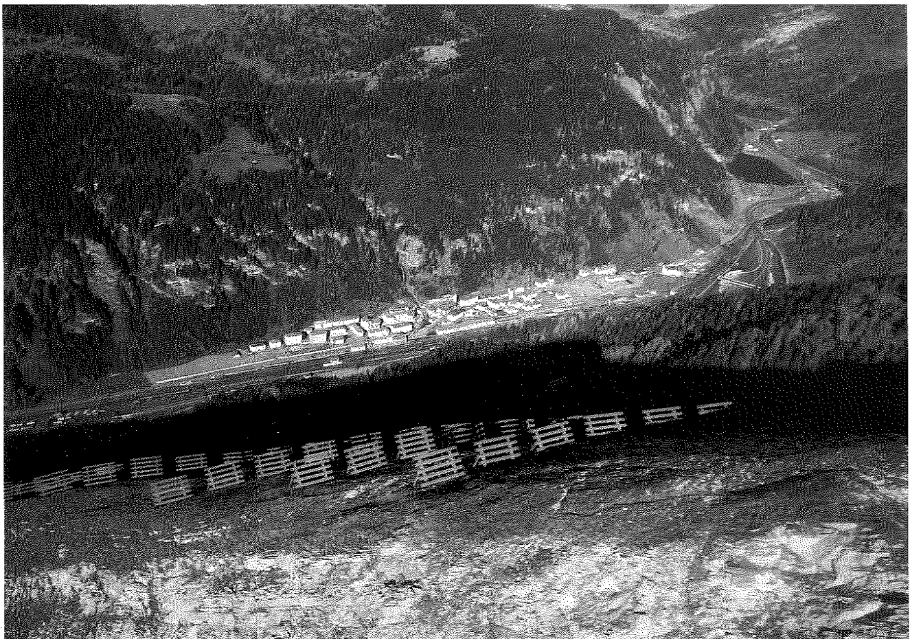
Fig. 1 Intervento di sistemazione con ponti da neve al Passo del Brennero (versante Vallaccia).
