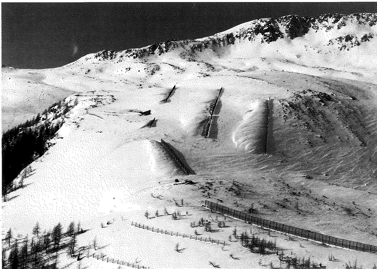
Fig. 3 Influenza delle staccionate sul deposito della neve trasportata dal vento (Predoi - Valle Aurina) (Foto: D. Santi)
