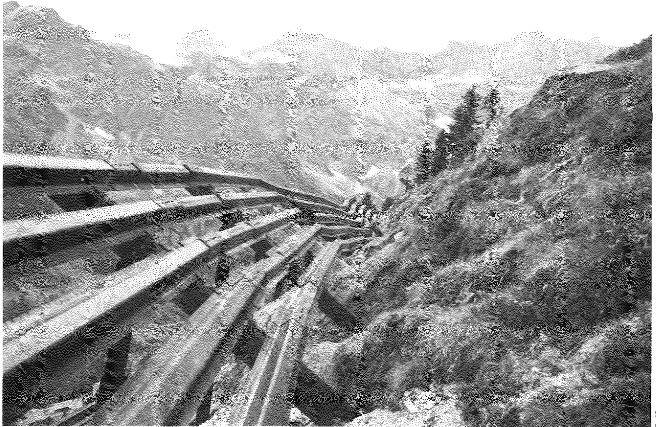
Fig. 2 Ponti da neve in disposizione continua (Foto: Regione Valle d'Aosta)
