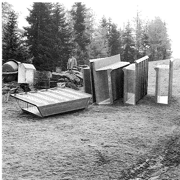
Fig. 2 Singoli componenti della vasca lisimetrica (Foto: Ufficio Idrografico-Servizio Prevenzione Valanghe - Provincia di Bolzano)
