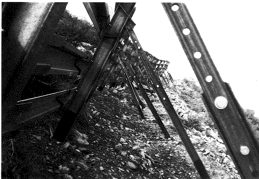
Fig. 4 Ponti da neve tradizionali: si evidenziano i notevoli movimenti di terra per la messa in opera delle singole strutture.
