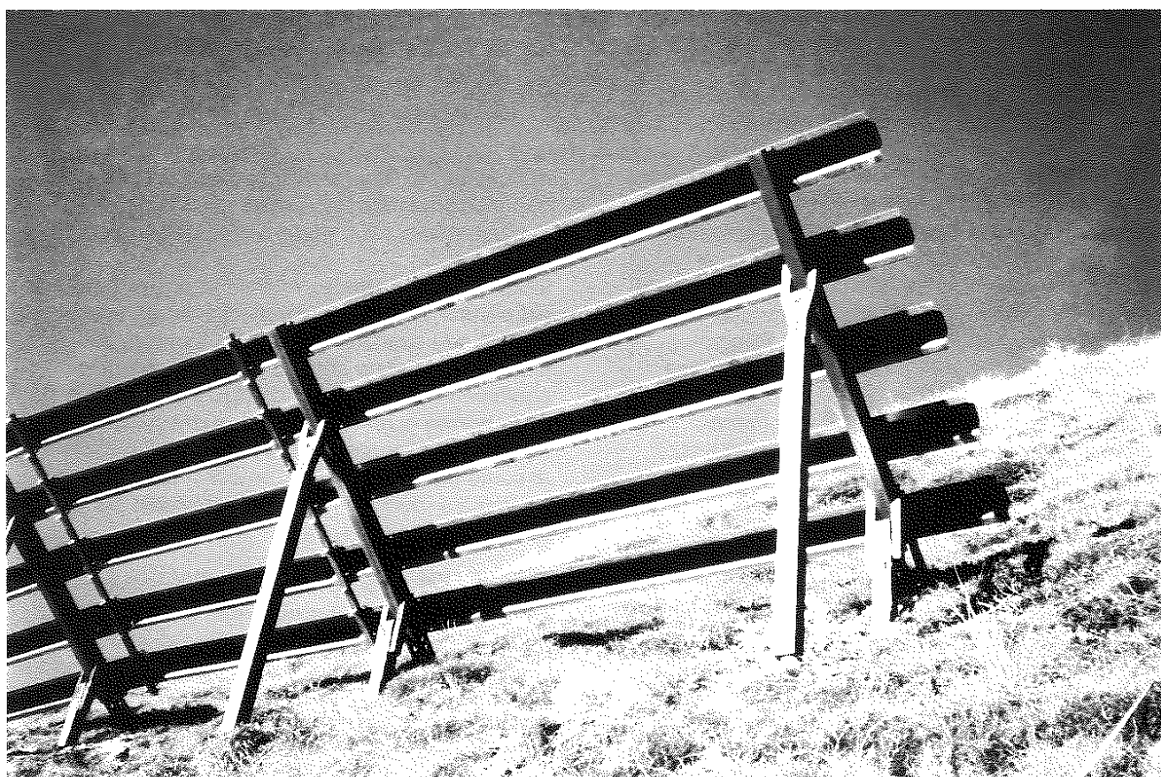
Fig. 2 Struttura Mair-HG messa in opera.
