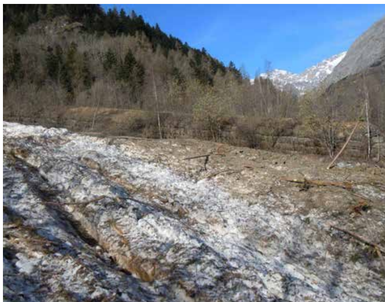
Fig. 1 - Foto inserita nel SIVA di un argine deviatore in terra armata che ha contenuto la valanga nella zona di arresto.
