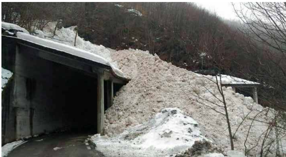
Fig. 12 - Dettaglio della zona di accumulo della valanga detta del "vallone Franco" dove si può notare come la galleria paravalanghe abbia svolto a pieno il compito di protezione.
