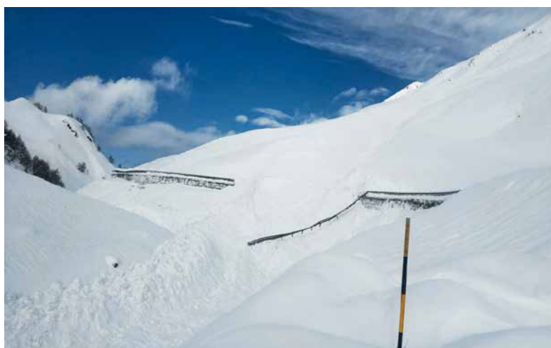
Fig. 5 - Valanga sulla strada statale del colle della Maddalena che ha divelto quasi 60m di guardrail.
