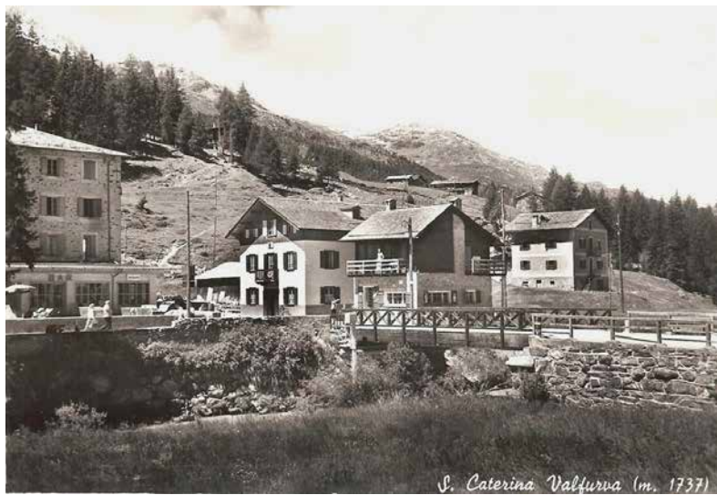
Fig. 11 - La stazione idrografica di S. Caterina Valfurva in una cartolina viaggiata nel 1958. Ubicata presso la spalla sinistra del ponte, una scala consentiva l'accesso alla strumentazione.
