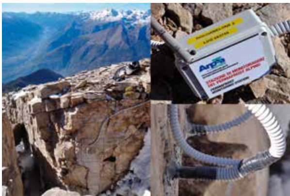
Fig. 8 - L'estensimetro E1, installato a fine ottobre 2014 in corrispondenza di una evidente frattura (F) del substrato roccioso lungo la cresta sud (A: punto di ancoraggio, B: tubo di protezione del cavo d'acciaio, C: trasduttore elettromeccanico, D: datalogger).
