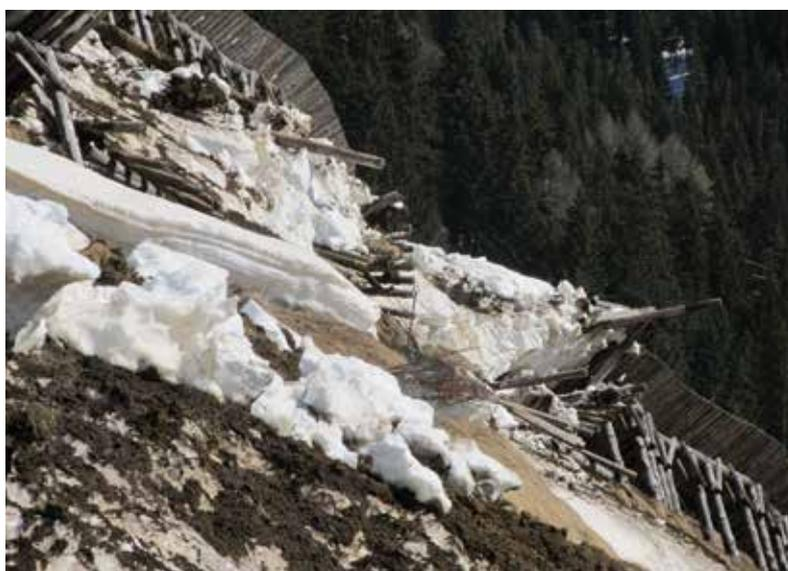
Fig. 24 - Particolare dei danni alle barriere fermaneve in legno.
