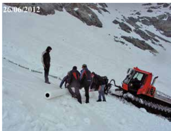
Fig. 1 - Collocazione dei geotessili al termine dell'attività sciistica.
