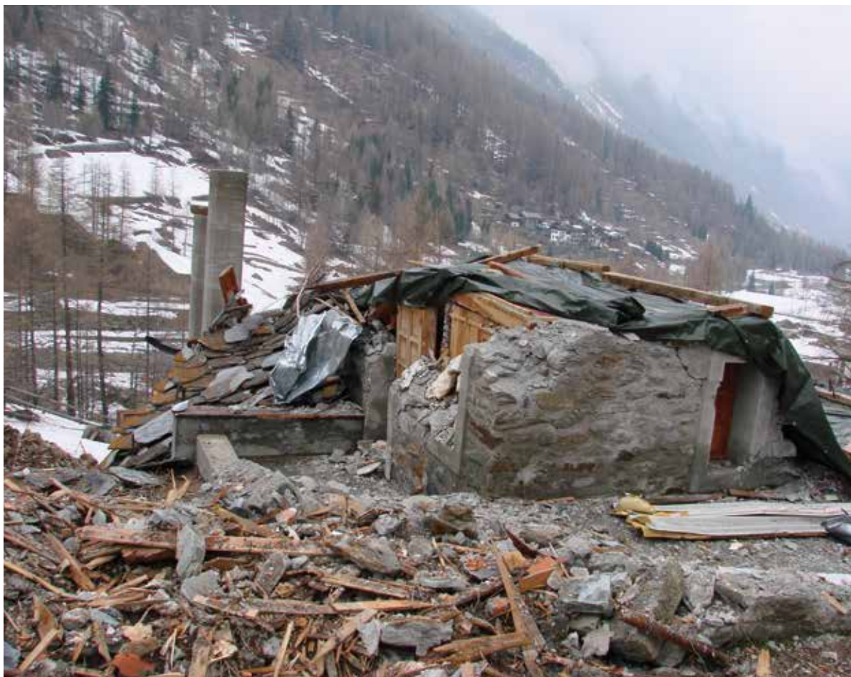
Fig. 4 - Localizzazione dei detriti attorno ad un'abitazione in muratura e calcestruzzo impattata dal ramo destro dell'evento del dicembre 2008 a valle degli Chalet n.1 e 2 oggetti di studio. Grazie all'analisi del deposito valanghivo, si possono comprendere le successive fasi di danneggiamento delle strutture coinvolte oltre a particolari sulla dinamica del fenomeno (Foto: Ufficio Neve e Valanghe - Regione autonoma Valle d'Aosta, 2009).
