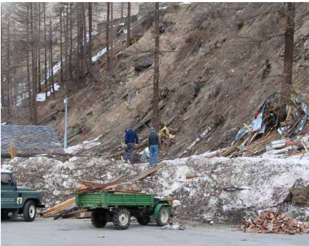
Fig. 5 - Aprile 2009: operazioni di sgombero neve e pulitura boschi e pascoli dai detriti trasportati dall'evento del dicembre 2008. Sulla sinistra, si noti la piegatura delle lamiere attorno al larice segno sia della direzione che della potenza del flusso valanghivo (Foto: Ufficio Neve e Valanghe - Regione autonoma Valle d'Aosta, 2009).
