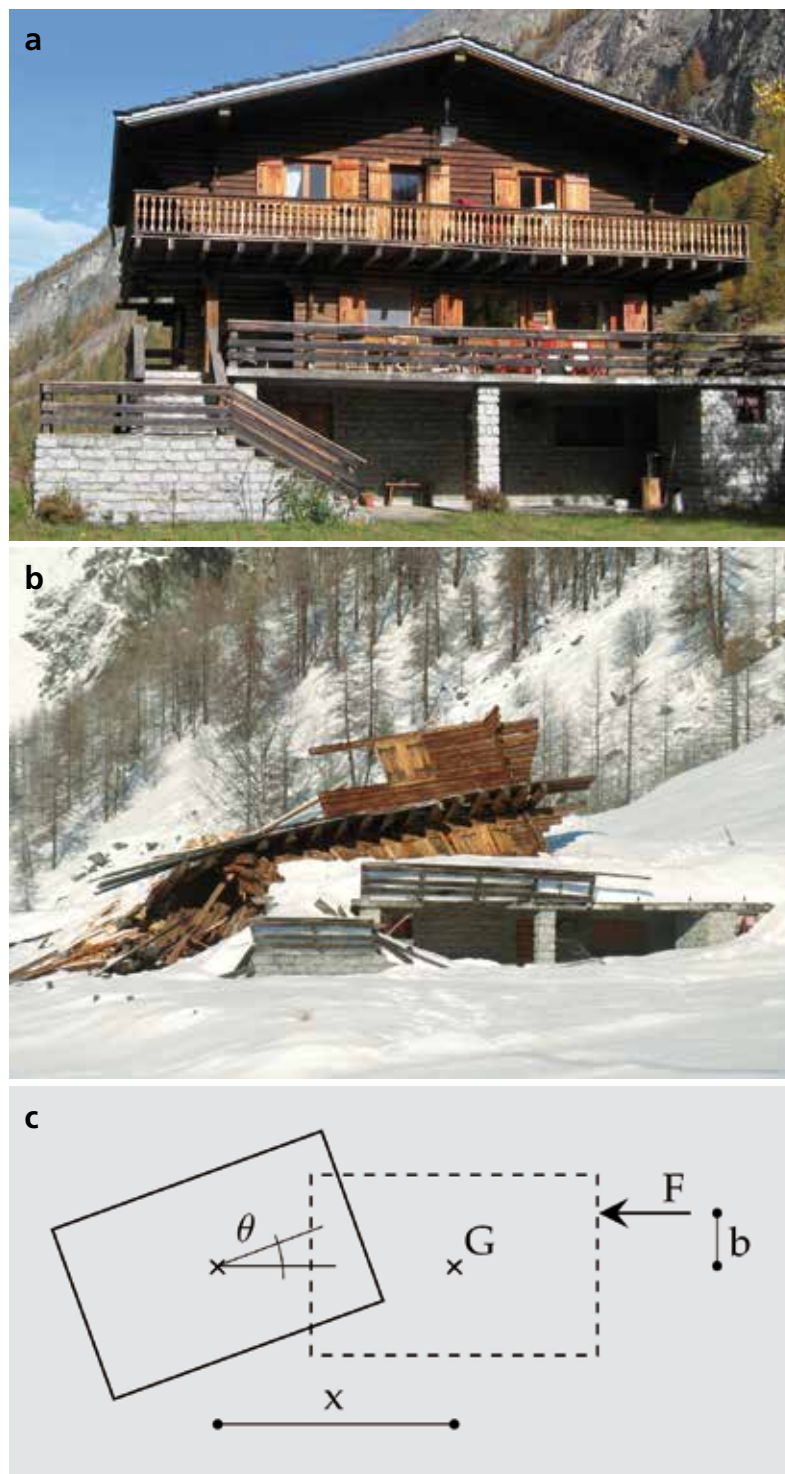
Fig. 6 - Due viste dello Chalet n.1: (a) prima dell'evento del 15 dicembre 2008 (Foto: fam. Chiaraviglio), (b) dopo l'impatto con la valanga (Foto: H. Fusinaz). In (c) vengono riportati i parametri del modello roto-trasazionale della costruzione al fine della stima della pressione d'impatto con metodo inverso (De Biagi et al.).
