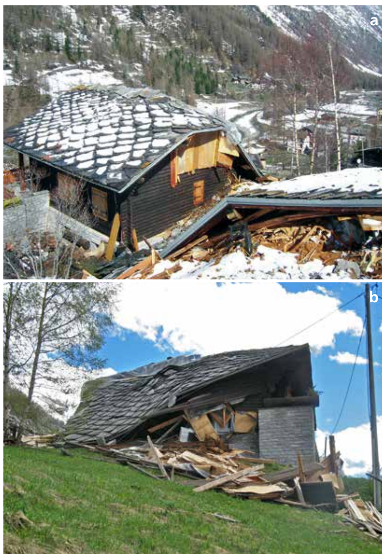
Fig. 7 - Due viste dello Chalet n.2 dopo l'impatto con la valanga del 15 dicembre 2008. (Foto: H. Fusinaz, V. De Biagi).
