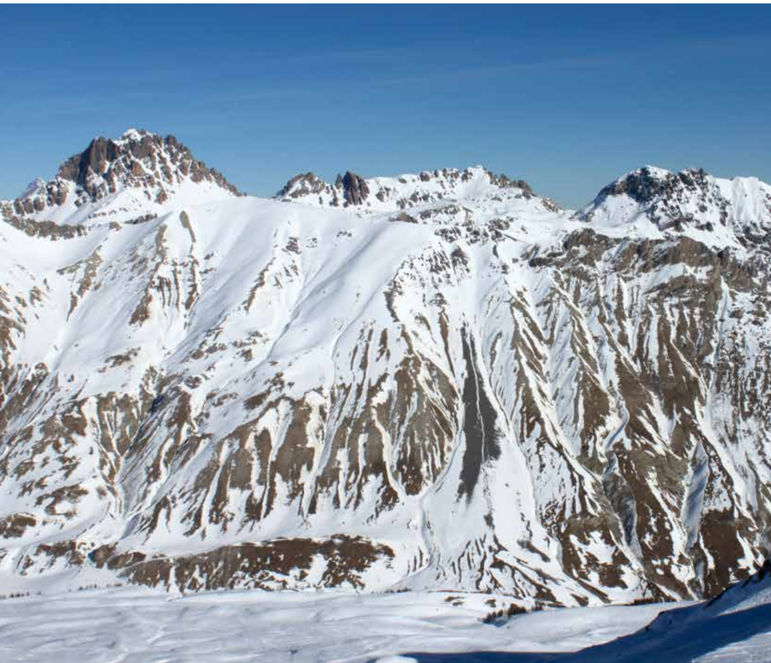
Fig. 4 - I percorsi valanghivi a monte di Argentera ripresi dal versante opposto. Sulla destra le zone di distacco e scorrimento delle valanghe tra la casa cantoniera e la Fontana di Napoleone, che raggiungono quasi sempre l'asse stradale.
