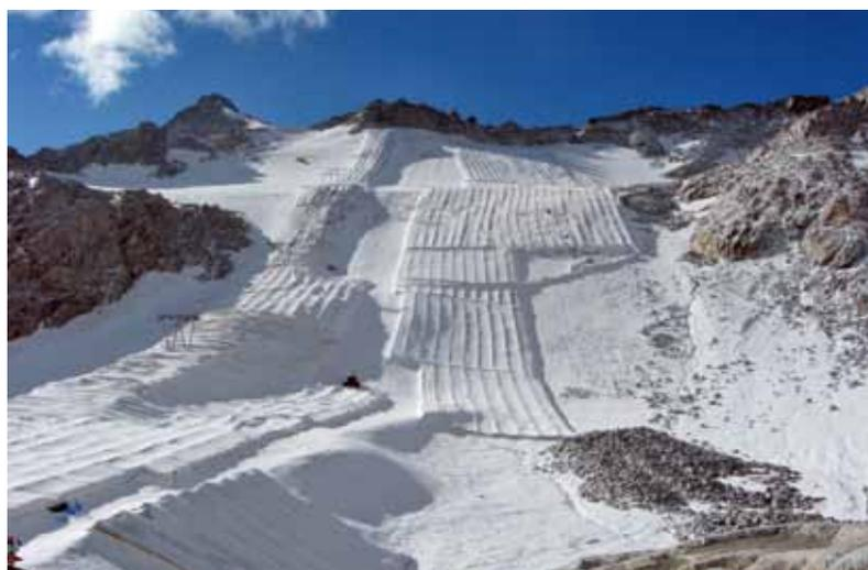
vuto essere alto almeno 3 m. In letteratura le percentuali di efficacia del geotessile nel ridurre l'ablazione variano dal 68,8% nel 2008 (Diolaiuti et al 2009a) al 60% nel 2003-2008 (Olefs e Fischer 2008), ma sono evidentemente condizionate dalle differenze di altitudine, di radiazione solare e di accumulo (Fischer et al 2011).
