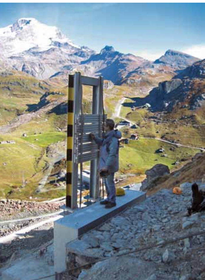
Fig. 5 - L'ostacolo a fine installazione in situ. Si possono notare i 5 traversi posti a differente altezza sull'ostacolo e l'uso della tettoia come piano di calpestio durante le operazioni di manutenzione.
