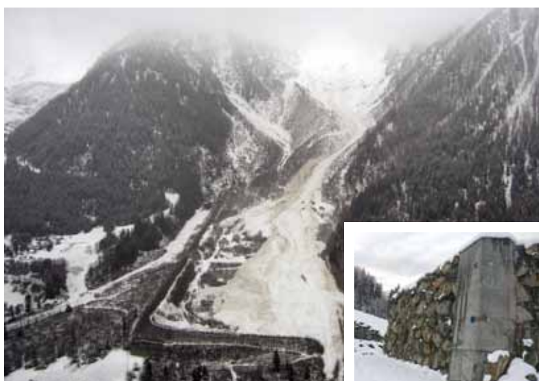
Fig. 3 - Dispositivo paravalanghe di Tacconaz. Evidenziato, in piccolo, un setto deviatore strumentato da due sensori di velocità e due di pressione (fonte RTM).
