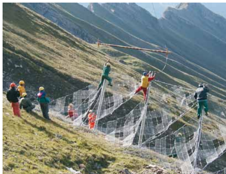
Montaggio di reti da neve omologate con impiego di elicottero.
