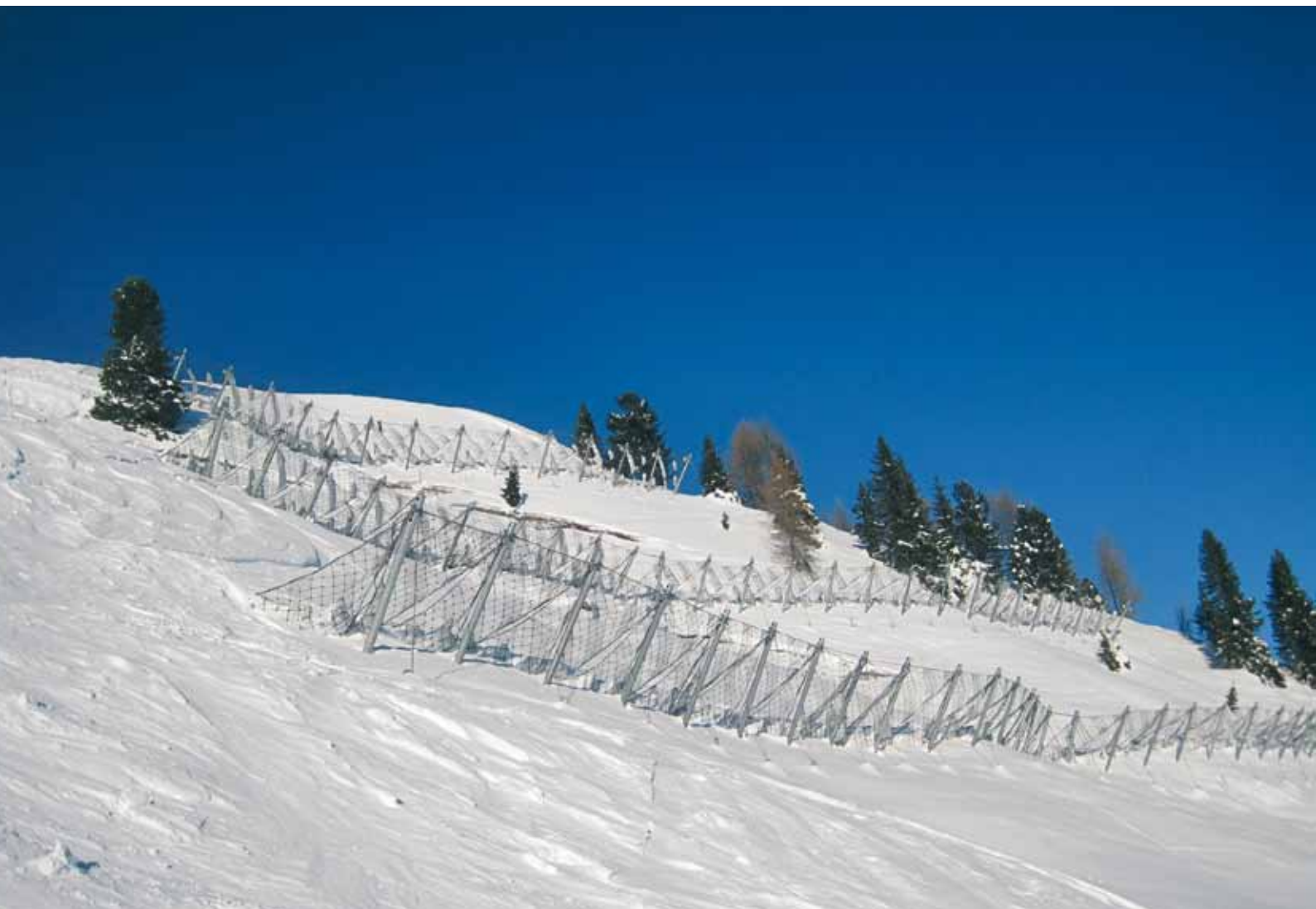
Strutture fermaneeve (reti) omologate in Italia (Dolomiti).
