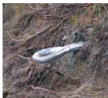
Fig. 9 - Particolare ancoraggio con doppia protezione dalla corrosione e redancia tubolare in acciaio inox in una struttura fermaneve omologata.
