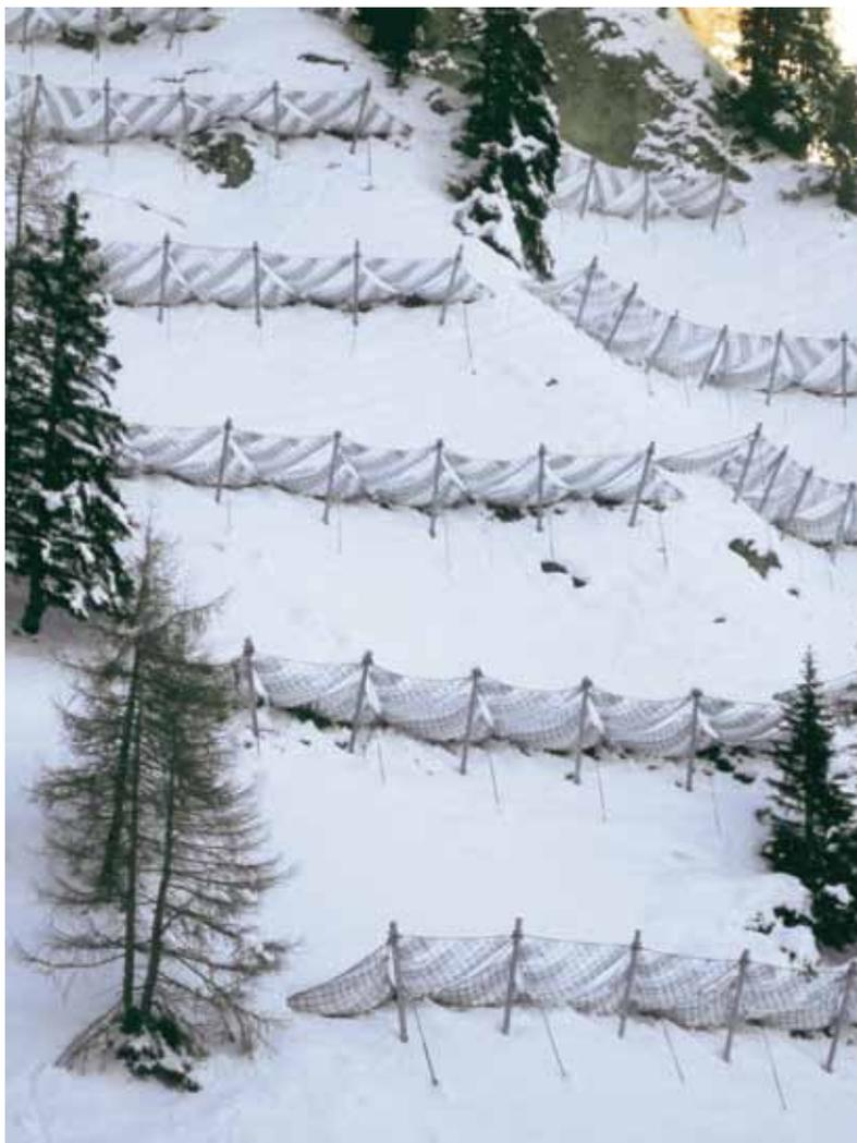
Fig. 7 - Puntoni tubolari piegati in strutture fermaneve non omologate.
