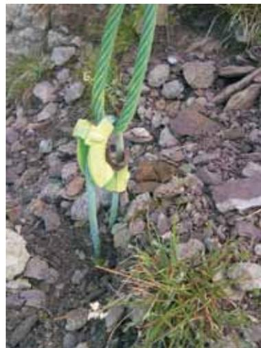
*Fig. 8 - Particolare di un ancoraggio non protetto dalla corrosione e con redancia rotta in strutture fermaneve non omologate.*
