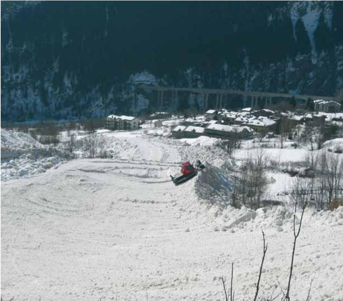
Fig. 10 - Rimodellamento della neve depositata dai tre eventi sul conoide di Lavanchers (marzo 2010).
