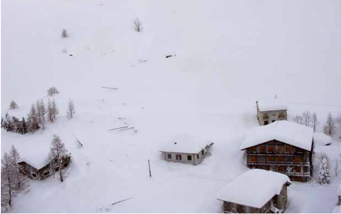
Fig. 14 Danni alle linee elettriche a Pontechianale in Val Varaita (foto Volo Provincia Cuneo).
