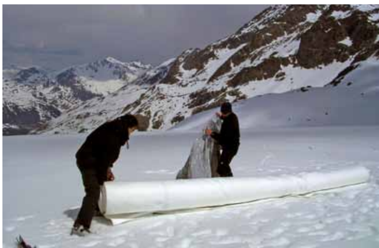
Fig. 4 Lo stendimento del geotessile sul Ghiacciaio di Dosdè Orientale.
