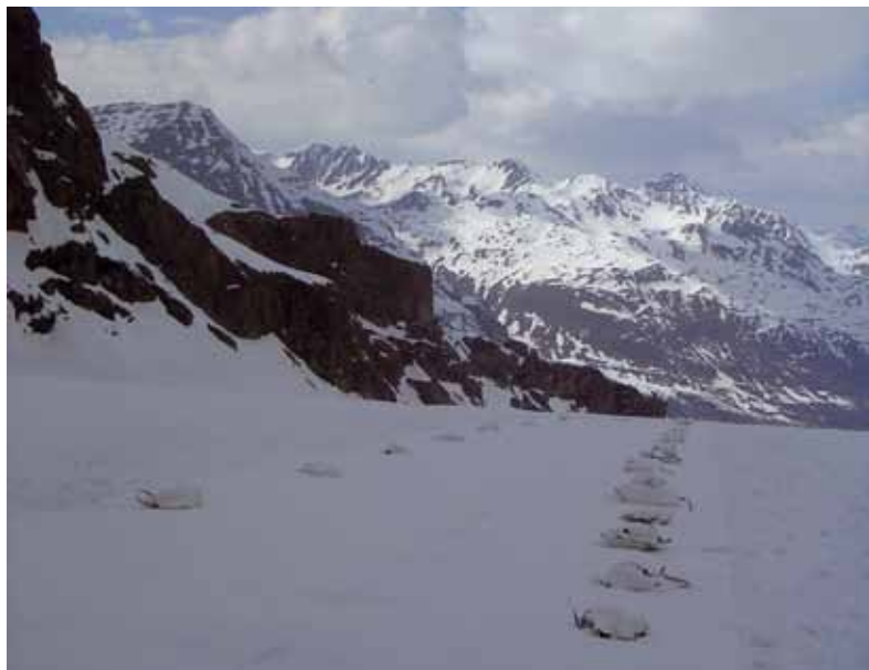
Fig. 5 La superficie della porzione di ghiacciaio ricoperta con geotessile al termine delle operazioni di ancoraggio del telo.
