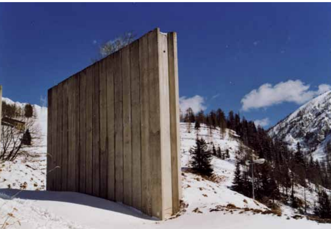
Sopra, denti frenanti I tipo a Foppolo (BG), in Valle Brembana.
