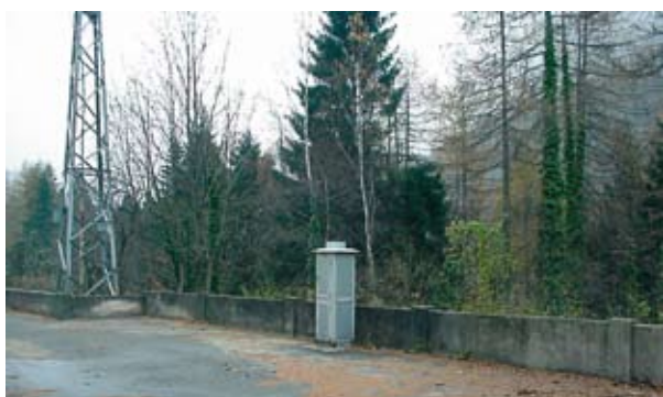
Fig. 5 - Stazione meteorologica SIMN di Ala di Stura (foto: ARPA Piemonte).
