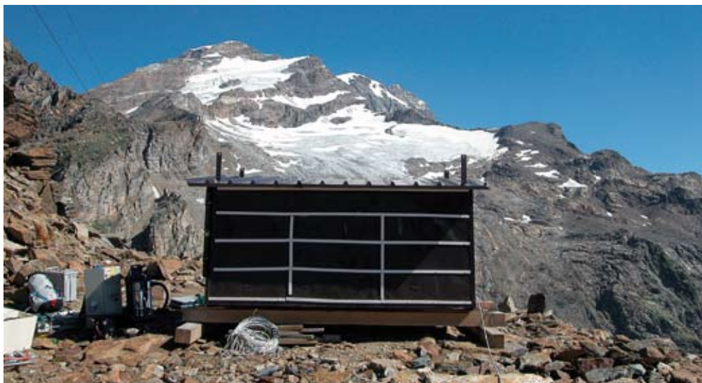
Fig. 1 - il sistema LISA al Passo dei Salati per il monitoraggio del ghiacciaio di Bors.
