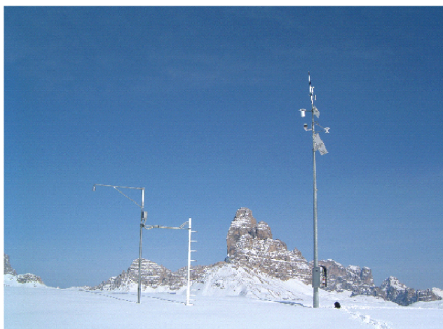
Fig. F.2.3.3.1 – Stazione nivometeorologica automatica di Monte Piana (Dolomiti settentrionali, Provincia di Belluno); in questo caso la stazione è costituita da un palo principale (sulla destra) su cui sono installati l'unità di gestione, i sistemi di alimentazione-trasmissione e i sensori meteorologici (termoigrometro, albedometro, anemometro e anemoscopio) e un palo secondario (sulla sinistra) a cui sono collegati i sensori nivologici (nevometro e termosonda); la stazione è inoltre dotata di una fotocamera fissa per l'osservazione del tempo presente (palo principale).
