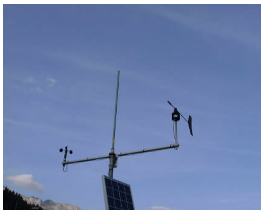
Fig. F.1.5.4.7.1- Sulle stazioni automatiche i sensori di velocità e direzione del vento vengono generalmente montati accoppiati alla stessa altezza su un apposito braccio di supporto.
