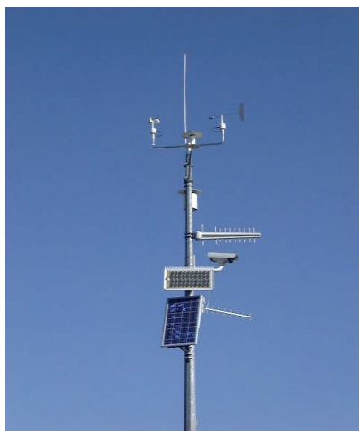
Fig. F.2.3.3.3.1 – Particolare dei sistemi di alimentazione (a pannelli fotovoltaici) e di trasmissione (via radio) di una stazione nivometeorologica automatica.
