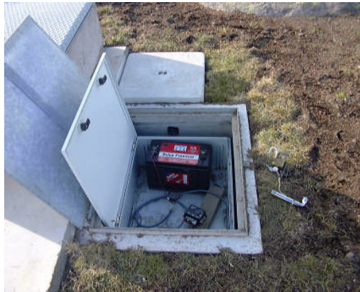
Fig. F.2.3.3.1.1 – Particolare del vano di alloggiamento degli accumulatori di una stazione nivometeorologica automatica (in questo caso il vano è interrato).
