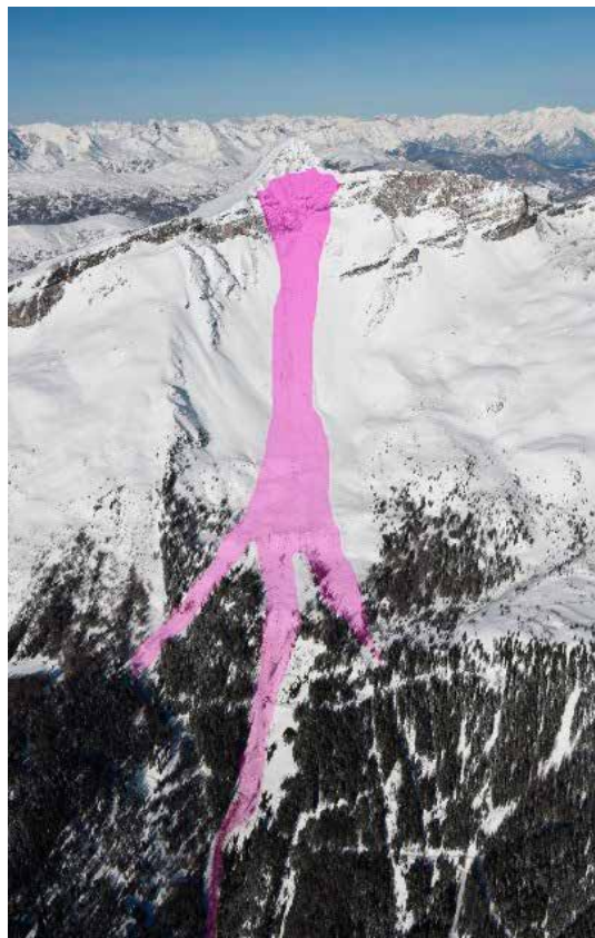
Fig. 9 - Valanga sulla Spina del Lupo che ha arrecato grossi danni al rifugio Grubberg (foto: Agenzia per la Protezione Civile, 16/01/2019).
