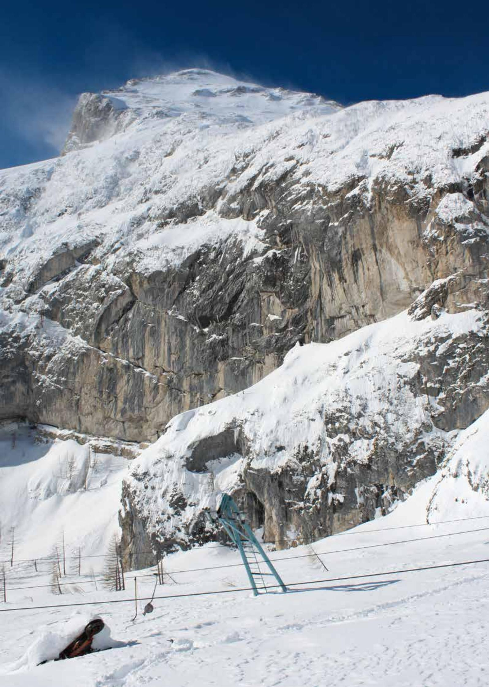
Fig. 1 - Danneggiamento della seggiovia "Capanna Bill - Passo Padon".
