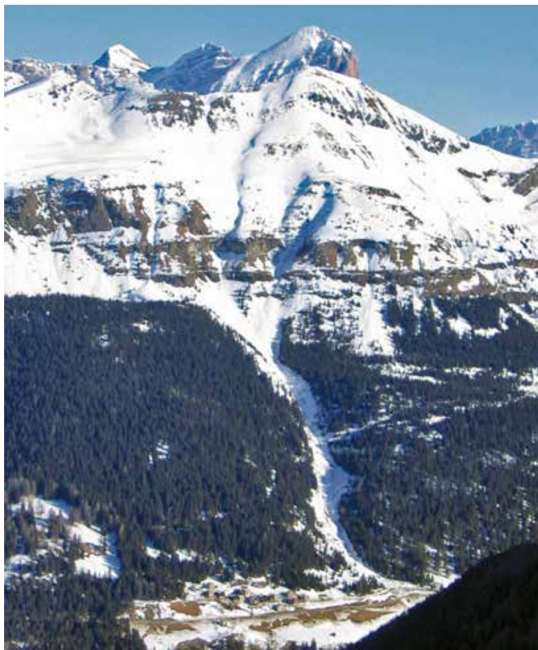
Fig. 2 - Zona di distacco e canale di scorrimento del sito valanghivo del Livinadac. Al centro dell'immagine si nota il centro abitato di Livinè, con la relativa strada comunale, e la strada regionale 48 delle Dolomiti.
