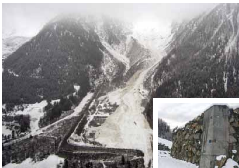
Fig. 3 - Dispositivo paravalanghe di Tacconaz. Evidenziato, in piccolo, un setto deviatore strumentato da due sensori di velocità e due di pressione (fonte RTM).
