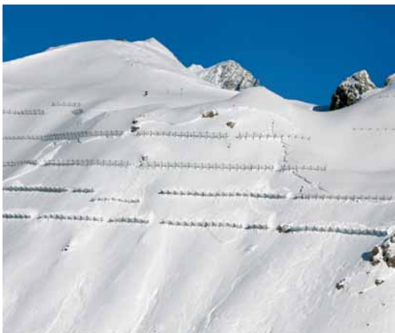
Fig. 4 - Particolare dell'area di distacco dell'evento di lunedì 1 marzo 2010 nei punti in cui la linea di frattura interseca le reti ferma-neve.
