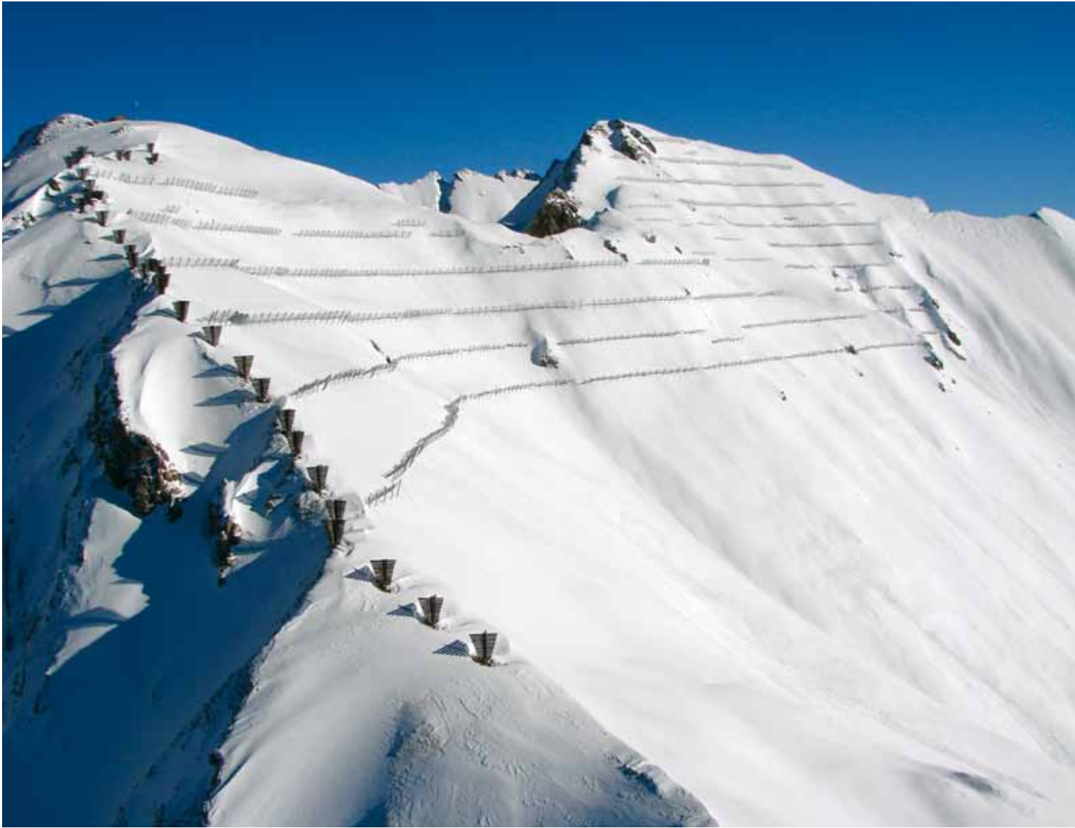
Fig. 2 - Le opere di difesa attiva realizzate nella porzione sommitale del bacino di Lavanchers a seguito dell'evento catastrofico del febbraio 1999.
