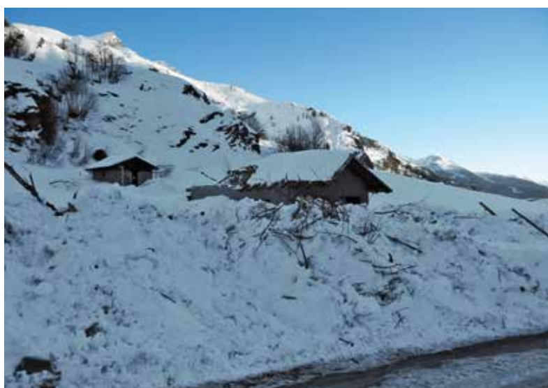
Fig. 48 - Valanga spontanea del 6 febbraio 2015 su strada, a Bellino (CN), con danni al garage.
