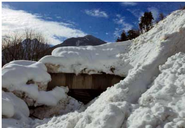
Fig. 49 - Valanga sul paravalanghe sulla SP della Valle Gesso, tra Entracque e Sant'Anna il 16 febbraio 2015, già caduta due volte a inizio mese.
